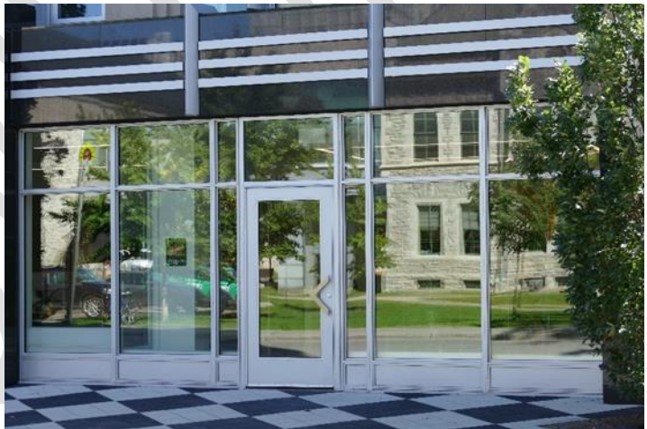
Figure 5 : Verre reflétant la végétation et les bâtiments d'en face.
