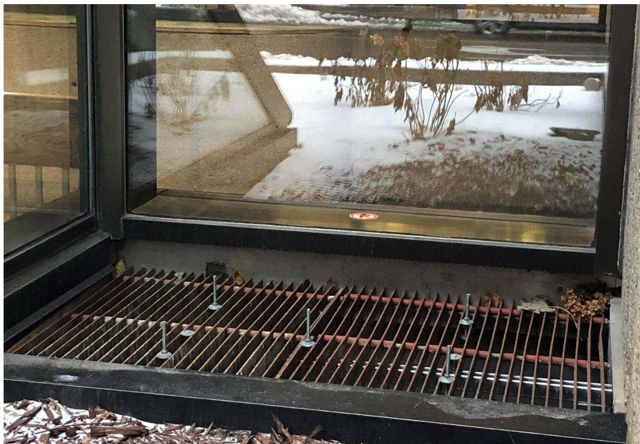
Figure 9 : Grille ouverte sous une fenêtre de verre réfléchissant.
